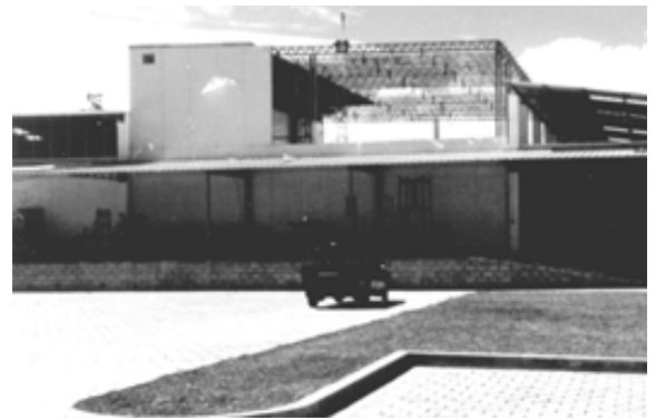
Del Tropic Foods (El Salvador) Cooler/Freezer de compartimientos multiples.
